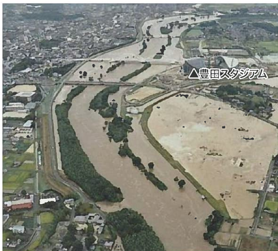
▲2000年9月東海豪雨、堤防を越水して氾濫した矢作川左岸 豊田スタジアム付近 (国交省中部地方整備局提供)
